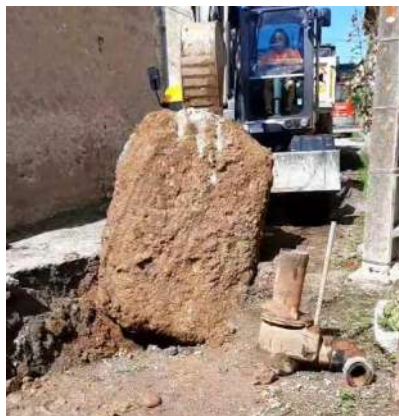
L'ANCIENNE CHASSE D'EAU DE LA RUE DU FROMENT
